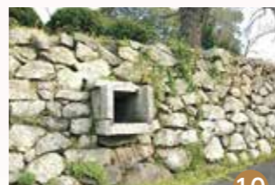
石樋 二の丸堀の水抜き石樋。元禄15年(1702)の修復で、木製から石の樋に替えられました。陸上競技場側に出口がみえます。
