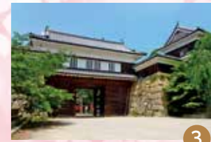
東虎口櫓門 昭和24年に南櫓と北櫓を移築復元し、平成6年に城門が復元され、かつての東虎口櫓門の姿がよみがえりました。
